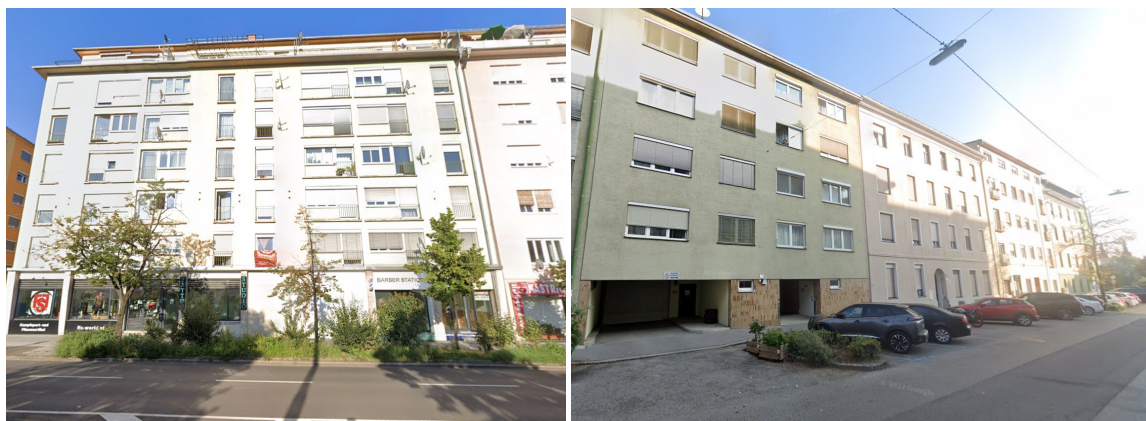
Abbildung 4: Fassadenansicht Bahnhofsgürtel (links) und Ghegagasse (rechts)
