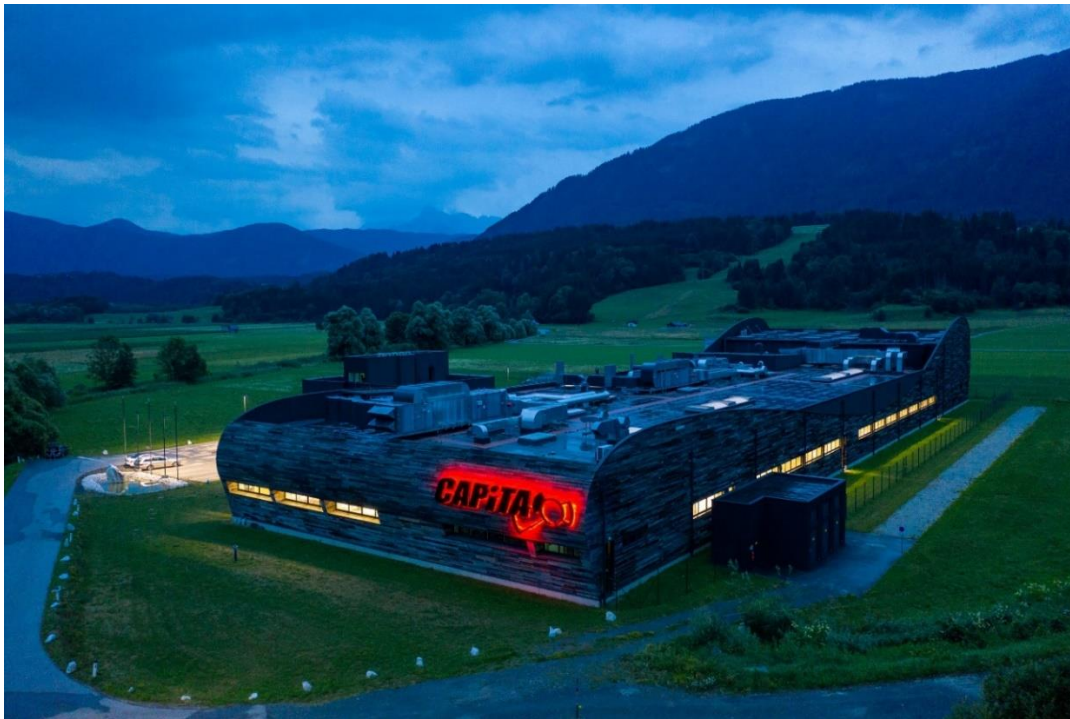
Abbildung 4: Firmengebäude von CAPiTA
