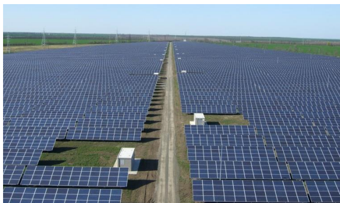
Z.B. Großkraftwerk mit 20 MWp 7 (© AIT) in Südosteuropa. Freifeld-Anlage, 40 Zentralwechselrichter, die paarweise über einen Blocktransformator ins Mittelspannungsnetz einspeisen.
