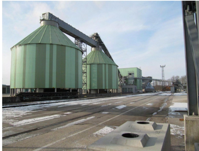
Abbildung 2.21: (links) Bunker für die zerkleinerten Alt- und Restholzbrennstoffe. (rechts) Brennstoffaufbereitung.
